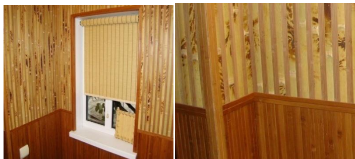
Рисунок 66 Отделка стен бамбуковыми панелями
