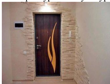
Рисунок 89 Отделка откосов фактурной штукатуркой
