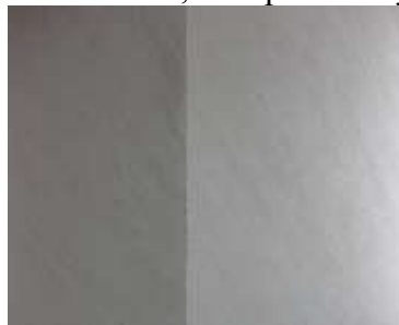
Рисунок 58 Покраска декоративной штукатурки
