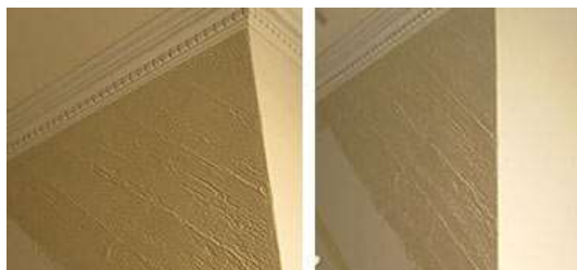
Рисунок 57 Процесс нанесения и разглаживания декоративной штукатурки
