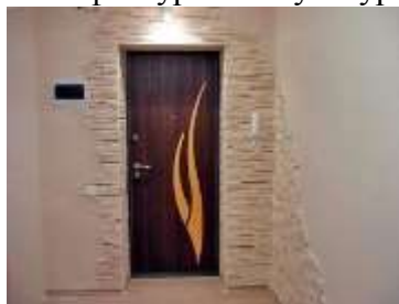
Рисунок 89 Отделка откосов фактурной штукатуркой
