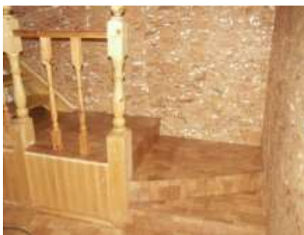
Рисунок 82 Отделка стен из пробкового покрытия
