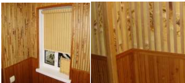
Рисунок 66 Отделка стен бамбуковыми панелями
