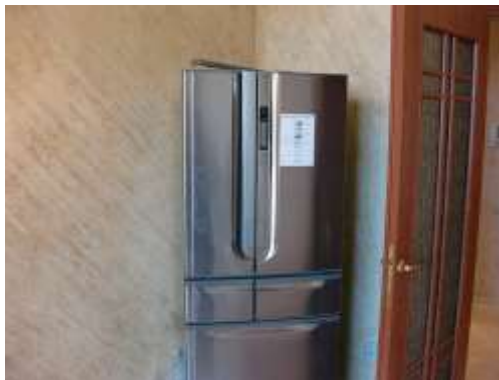
Рисунок 56 Декоративная штукатурка «дождик» на кухне
