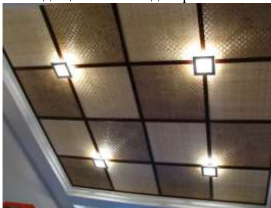
Рисунок 65 Потолок из бамбуковых плит
