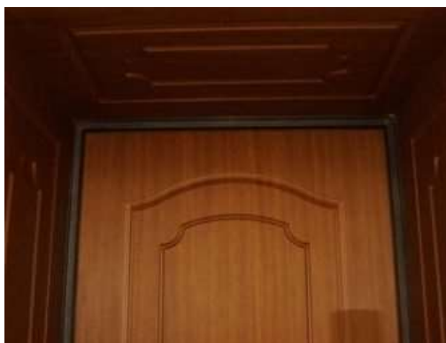
Рисунок 90 Отделка откосов шпоном
