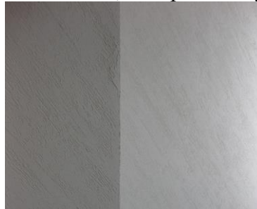
Рисунок 58 Покраска декоративной штукатурки
