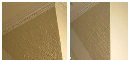
Рисунок 57 Процесс нанесения и разглаживания декоративной штукатурки
