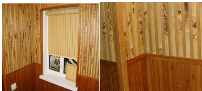
Рисунок 66 Отделка стен бамбуковыми панелями
