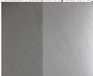
Рисунок 58 Покраска декоративной штукатурки
