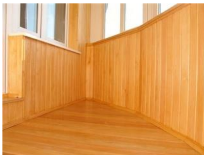
Рисунок 81 Балкон, обшитый вагонкой Покрытия для стен
