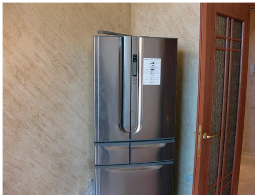
Рисунок 56 Декоративная штукатурка «дождик» на кухне
