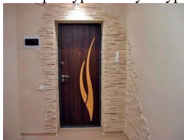
Рисунок 89 Отделка откосов фактурной штукатуркой
