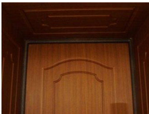
Рисунок 90 Отделка откосов шпоном
