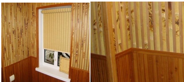
Рисунок 66 Отделка стен бамбуковыми панелями
