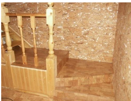
Рисунок 82 Отделка стен из пробкового покрытия
