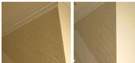
Рисунок 57 Процесс нанесения и разглаживания декоративной штукатурки
