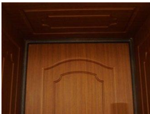
Рисунок 90 Отделка откосов шпоном
